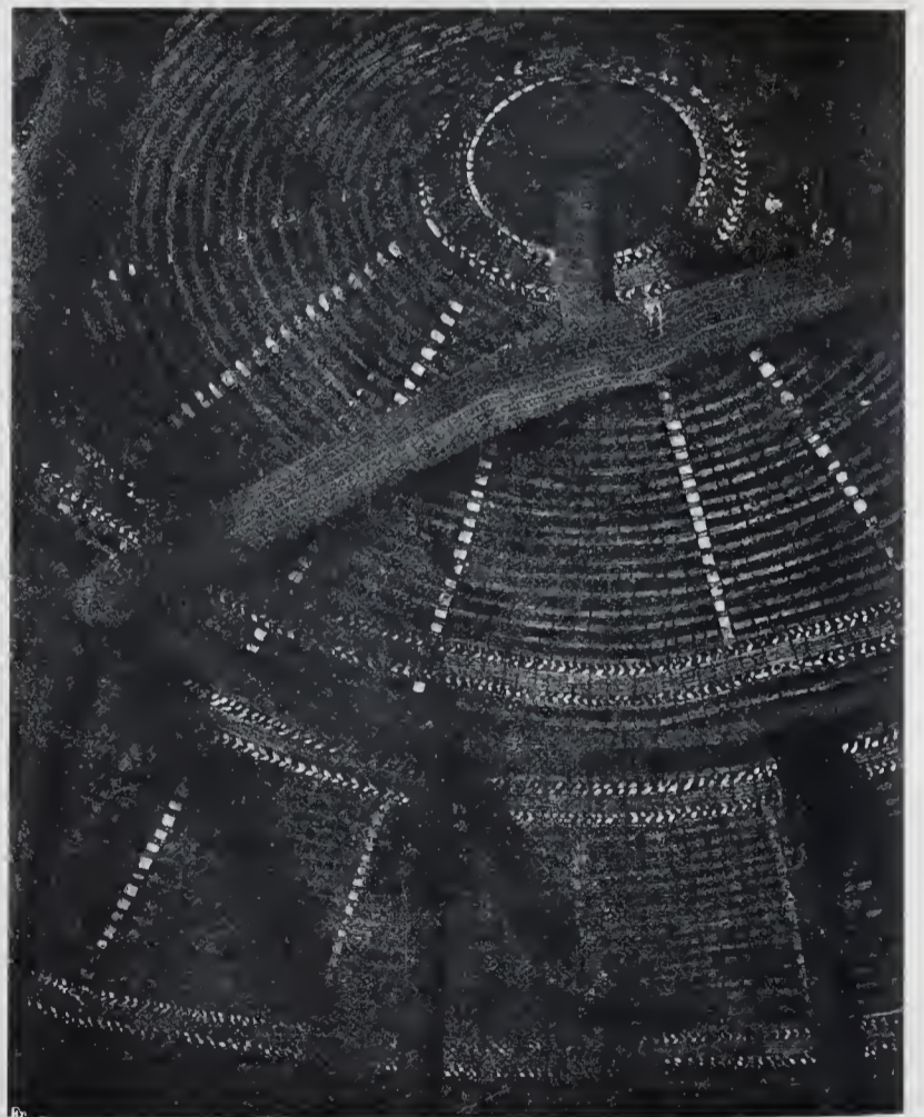
Abb. 21. Deckenunterstützung durch Holzstützenkranz mit mittlerer Pfette und durch Firststiel. Aksum.
